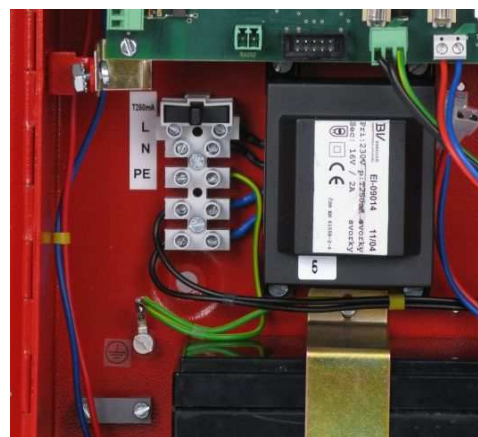
Obr. 5 - svorkovnice připojení síťového napájení
