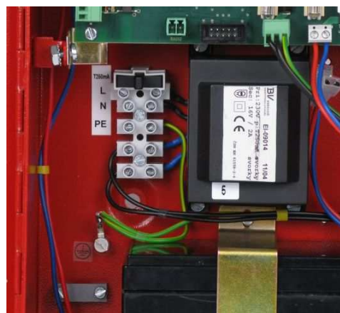
Obr. 5 - svorkovnice připojení síťového napájení
